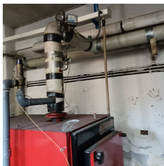
Generatore termico ACS esistente
